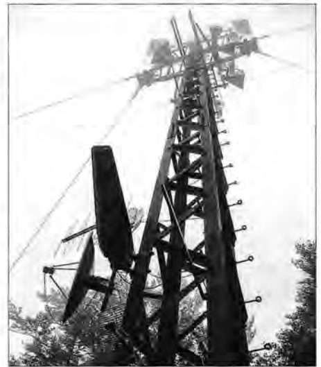
Der Antennenmast am Kaiserkogel – derzeit mit aktiven Baken auf 10 m, 6 m, 70 cm und 10 GHz Foto: OE3KLU
