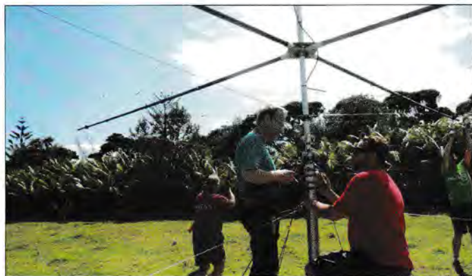
Beim Zusammenbau des Spiderbeams für 12 m
